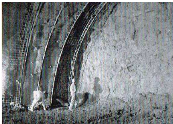
Bild 2 Aufstellen der Stützbögen
