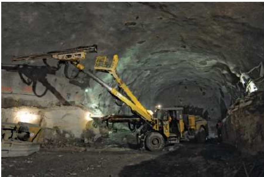
Bild 3 Vortriebsbohrwagen
